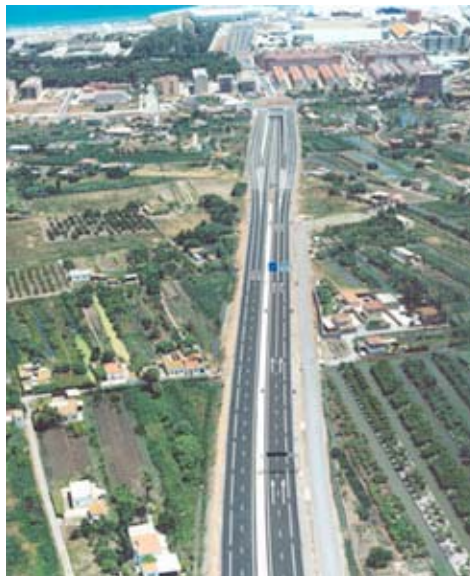
Nueva carretera de acceso al Puerto de Castellón
