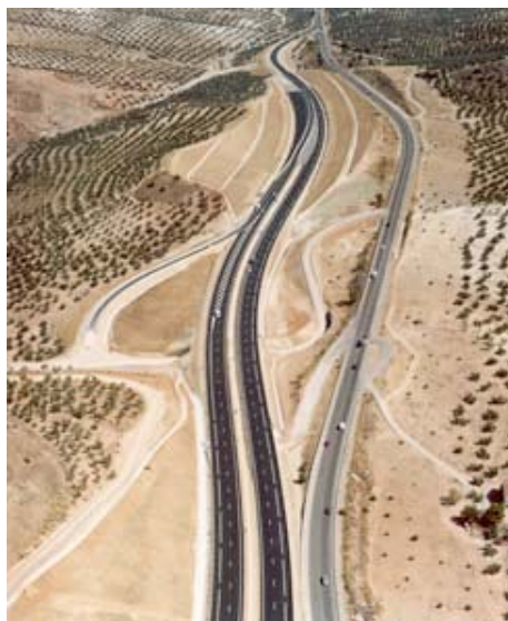
Nuevo enlace oeste de Mancha Real a variante noroeste de Jaén
